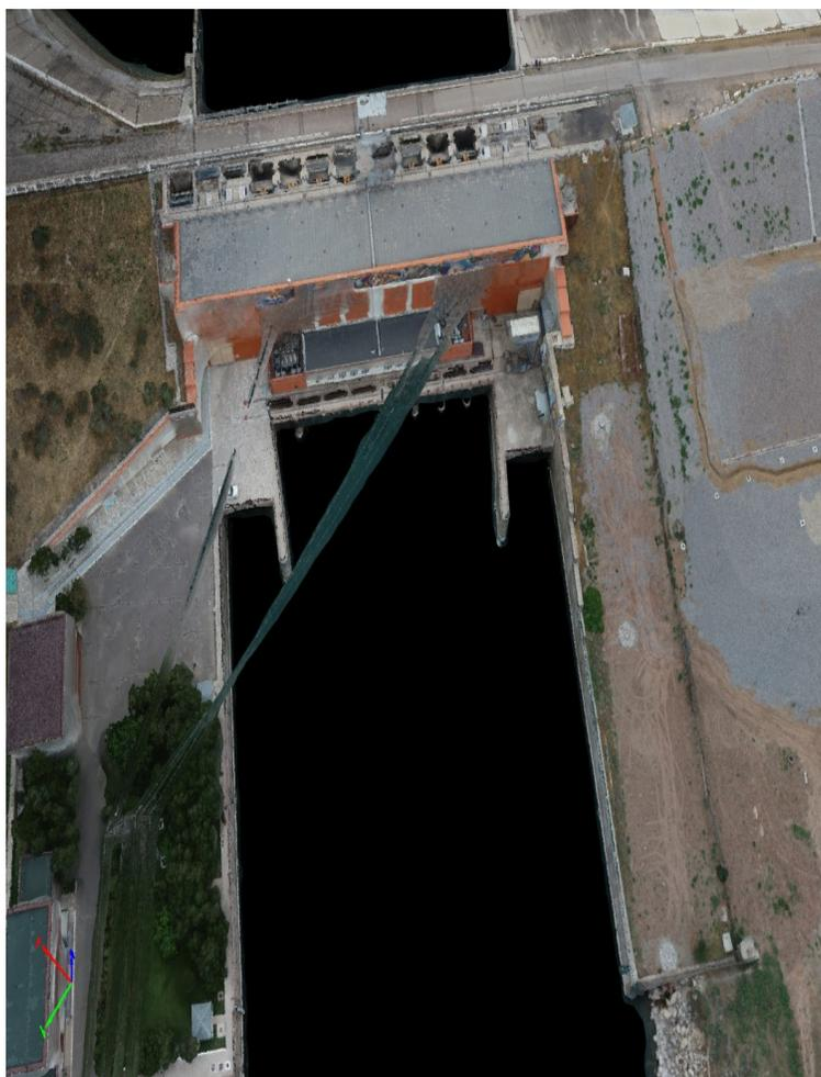
Рисунок 2.6. Обследование здания и отводящего канала Шардаринского водохранилища (съемка лидаром системы «Лидар DJI Zenmuse L1») с БПЛА «DJI Matrice 300 RTK».
